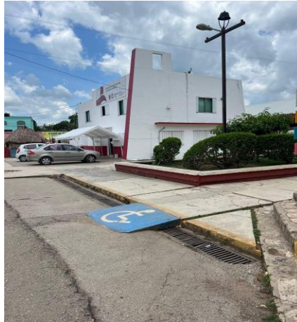
Fotografía 8. Rampa de Discapacitados en la Explanada Central de Kantunilkín. Fotografía a partir de exploración de campo.
