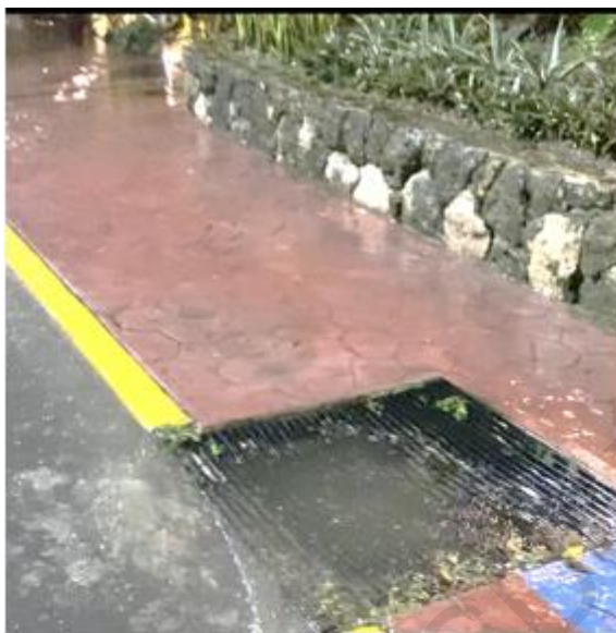
Figuras 97, 98 y 99. Ejemplo de pozo de absorción pluvial con mal funcionamiento para conversión en jardín de lluvia, Bacalar.
