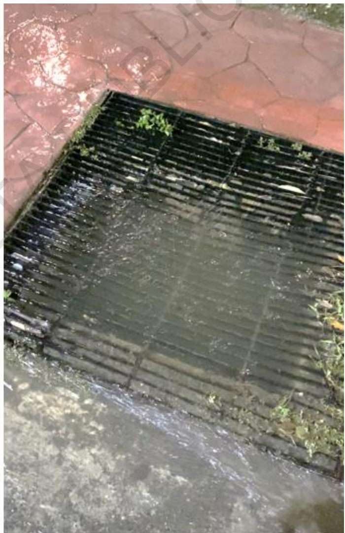
Figuras 97, 98 y 99. Ejemplo de pozo de absorción pluvial con mal funcionamiento para conversión en jardín de lluvia, Bacalar.
