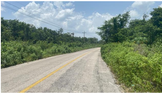
Imagen X. Carretera Nuevo Xcán - Cobá
